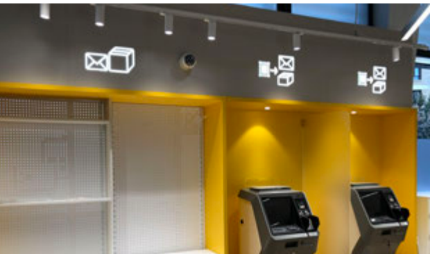
SIGNALÉTIQUE LUMINEUSE EN BLOC LED
